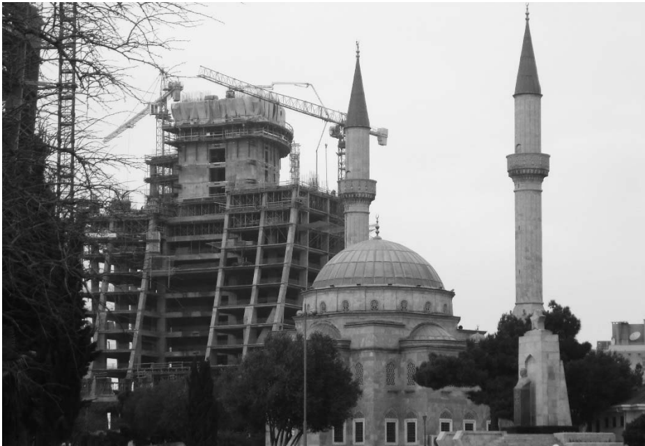
Die Märtyrer-Moschee (Şahidlər məscidi) in Baku nach ihrer Schließung 2009. Im Hintergrund der Rohbau der Flame Towers
